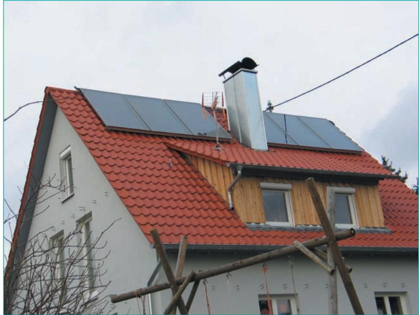
Abb. 1 – Solarthermie im Altbau.
